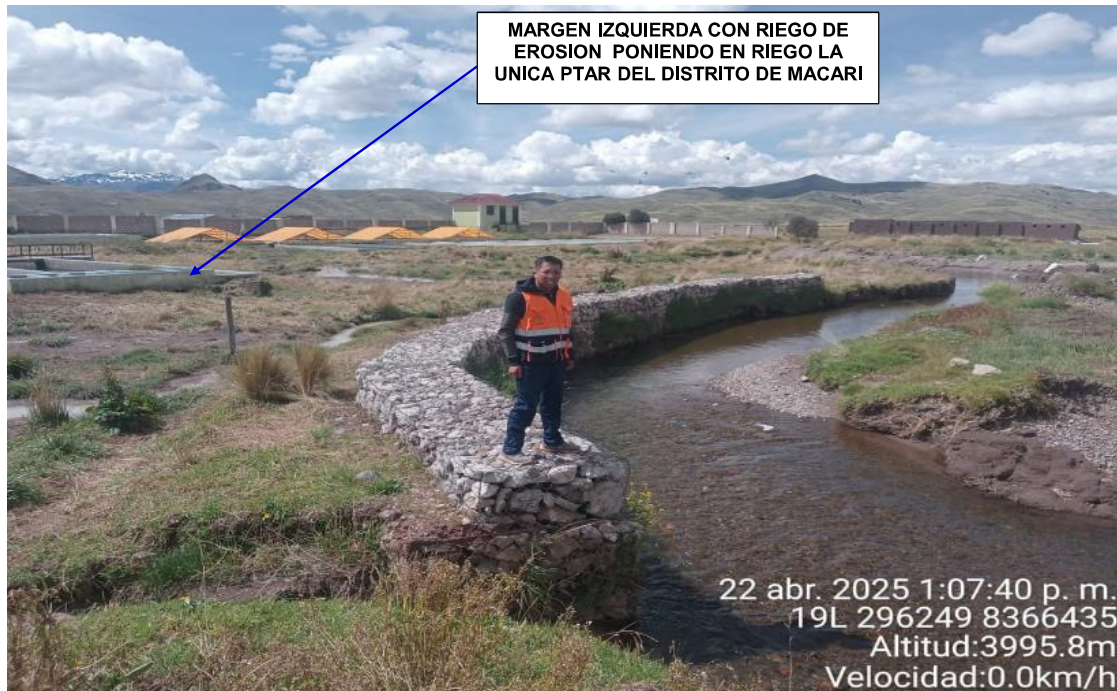
FIGURA N° 02: RIO TURMANA LA MARGEN IZQUIERDA, VULNERABLE A LA EROSION PONIENDO EN RIESGO LA PTAR DEL DISTRITO DE MACARI Y SE EVIDENCIA GAVIONES EXISTENTES EN
